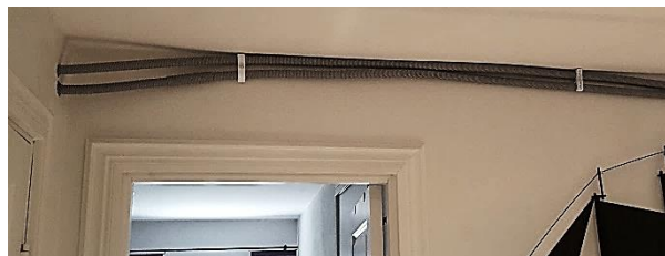
Indragna rör placerade i takvinkel
